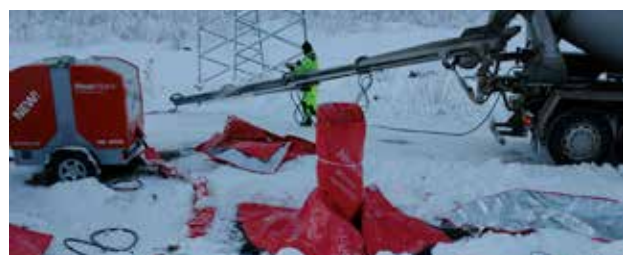
På bildene ser du Betongrenovering Rehab AS som er igang med støping av mastefundamenter på oppdrag fra Statnett.
